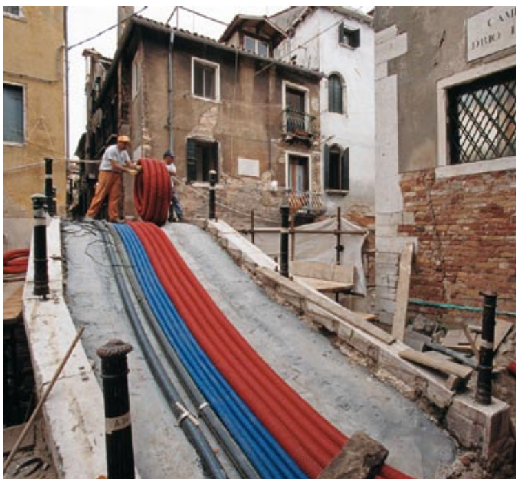
Bridge over Rio de la Pietà.
