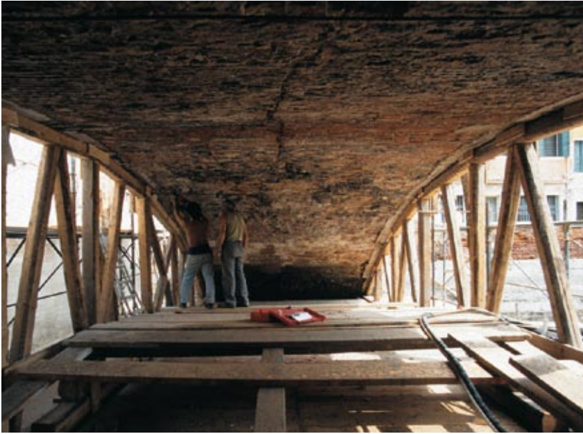
Bridge of San Girolamo.
