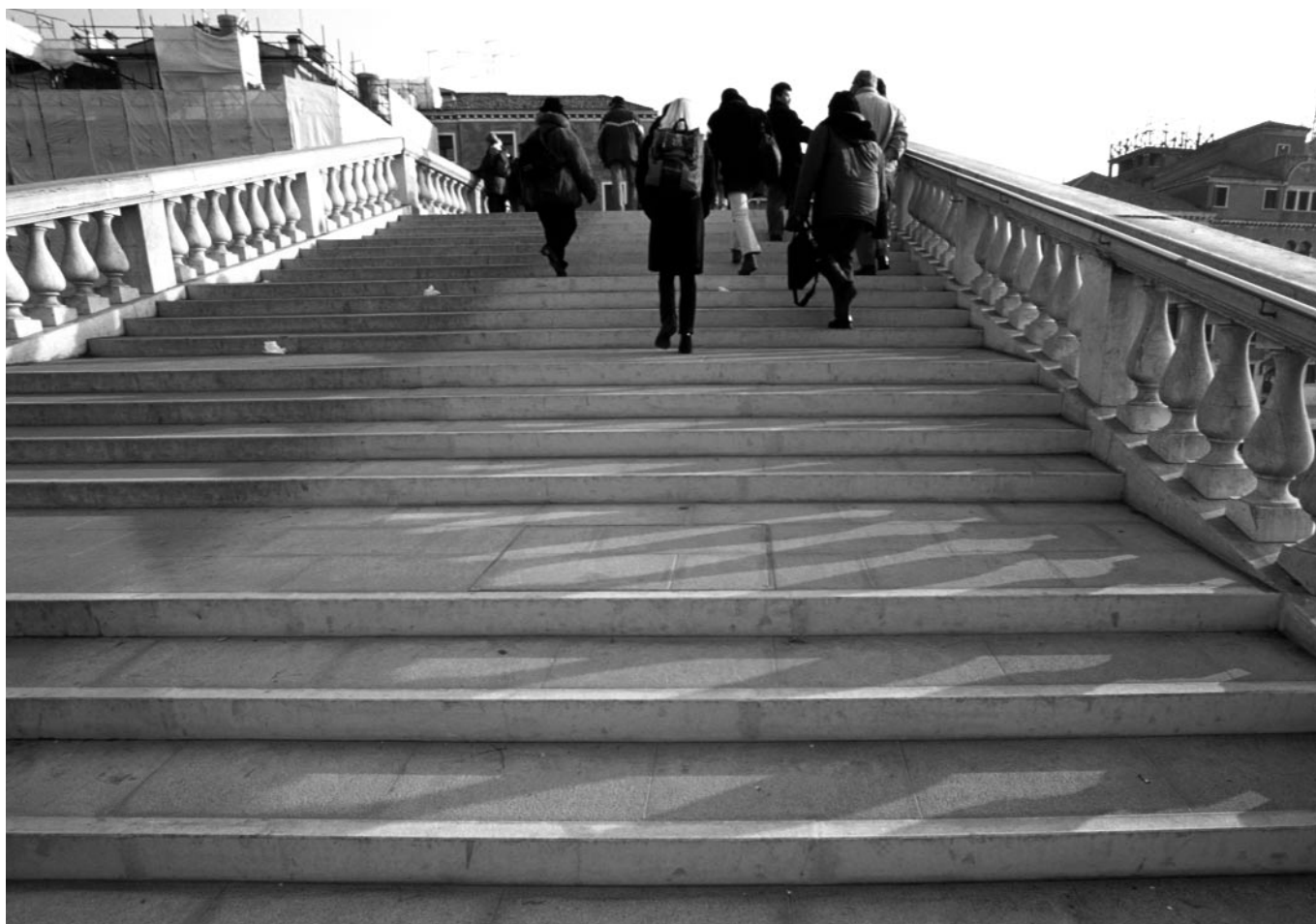
Il Ponte degli Scalzi con la nuova pavimentazione
