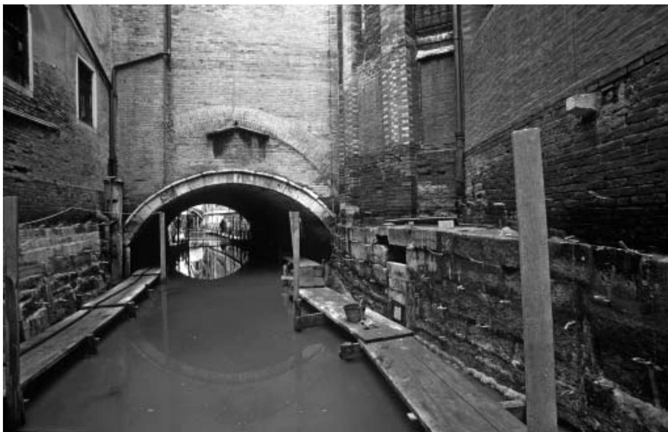
L'intervento di restauro dei muri di sponda di rio del Santissimo, febbraio 2001
