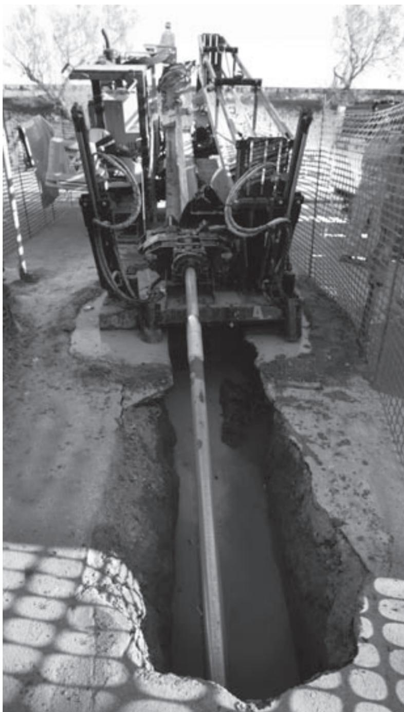
Posa in opera della rete fognaria mediante trivellazione orizzontale teleguidata.
