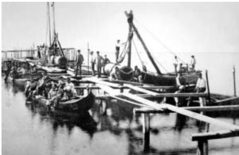
La costruzione dell'acquedotto, 1883
