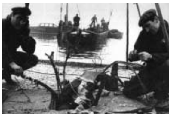
Giunzione di nuovi cavi telefonici sotterranei, 1963
