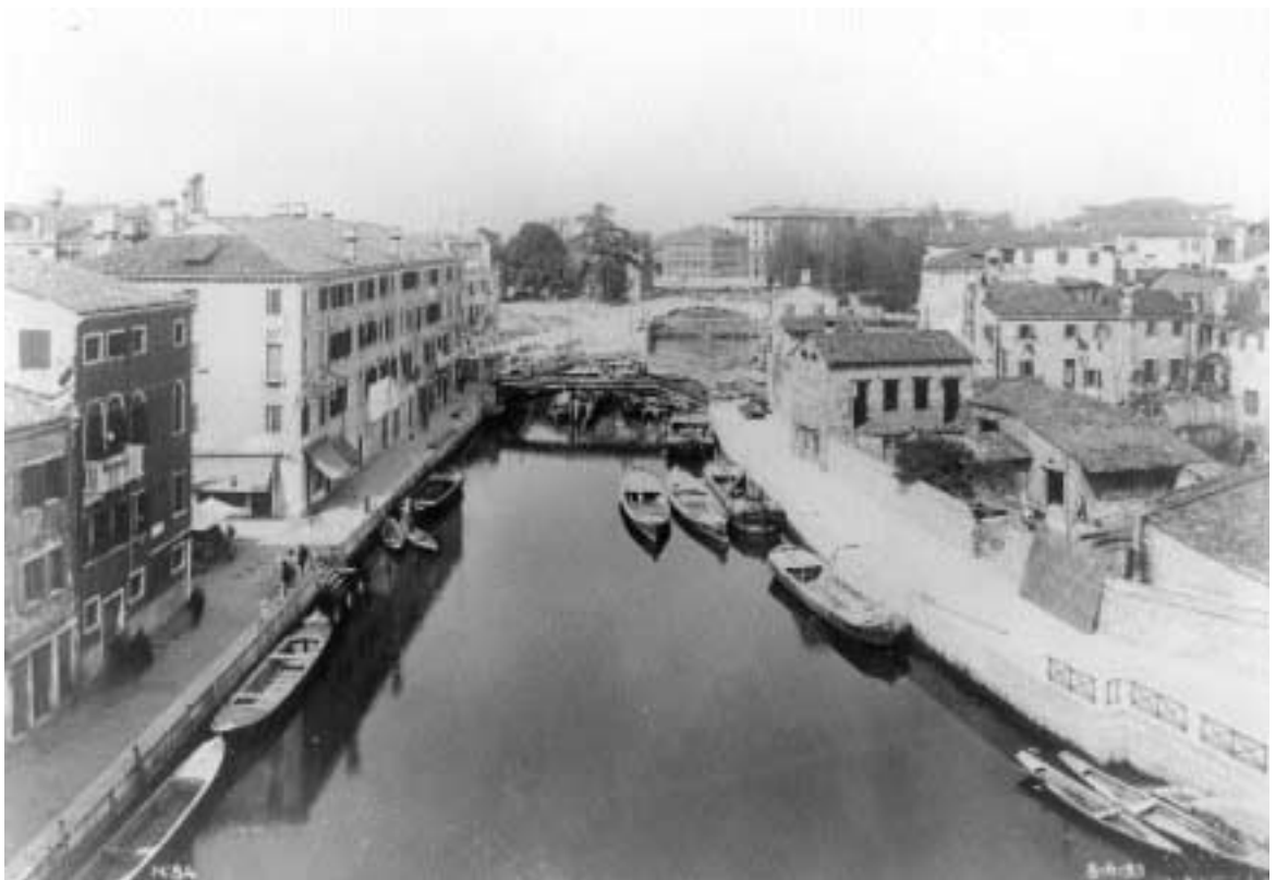
I lavori per l'apertura del Piazzale Roma e del Rio Nuovo. A destra, la cereria prima della demolizione, 8.4.1933
