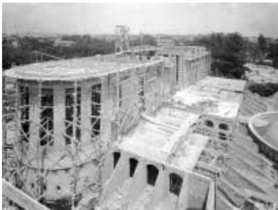
Lido di Venezia, la costruzione del Casinò municipale, 1937
