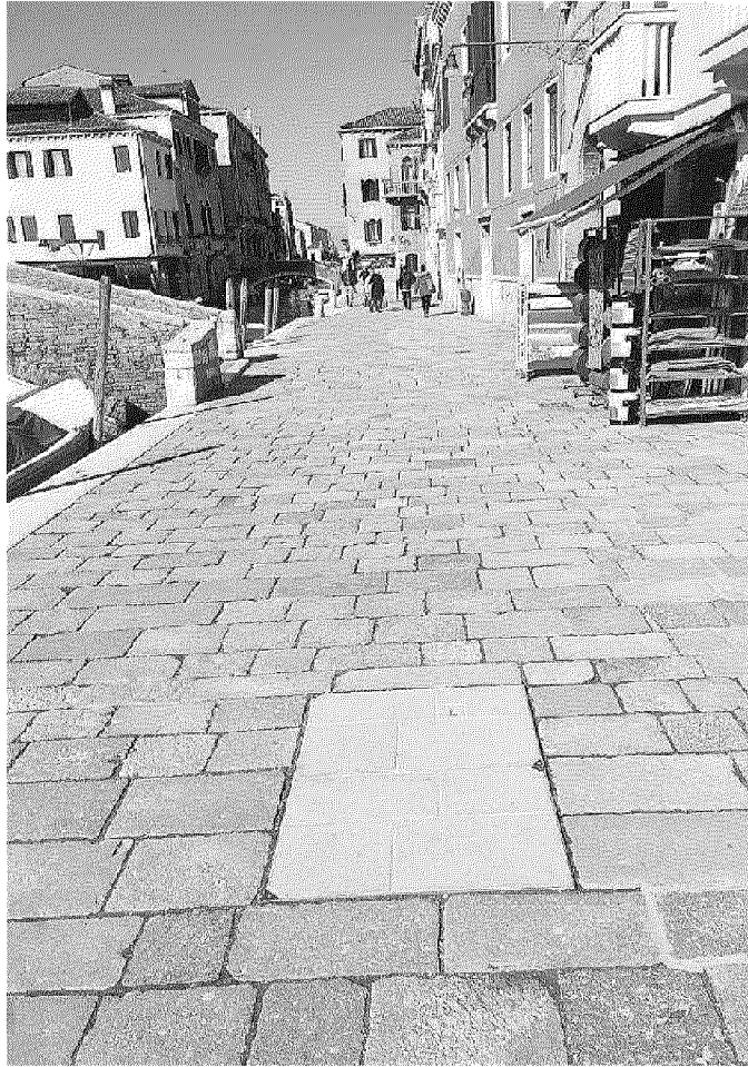
Masegni rattoppati: un esempio in Fondamenta della Misericordia
