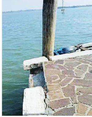
La pavimentazione rotta
