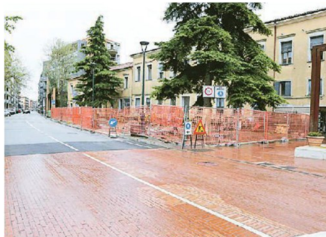
Il cantiere aperto all'ex scuola De Amicis
