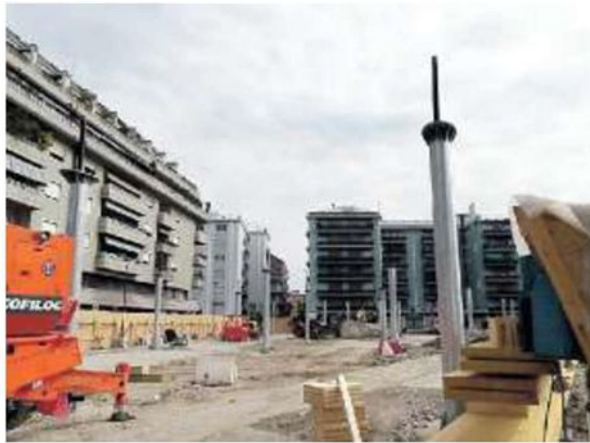
MERCATO I pilastri che sosterranno la nuova copertura del mercato di via Fapanni in legno lamellare
