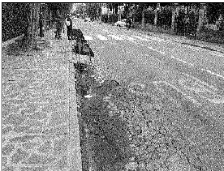
LIDO Via Sandro Gallo ha bisogno urgente di interventi di sistemazione
