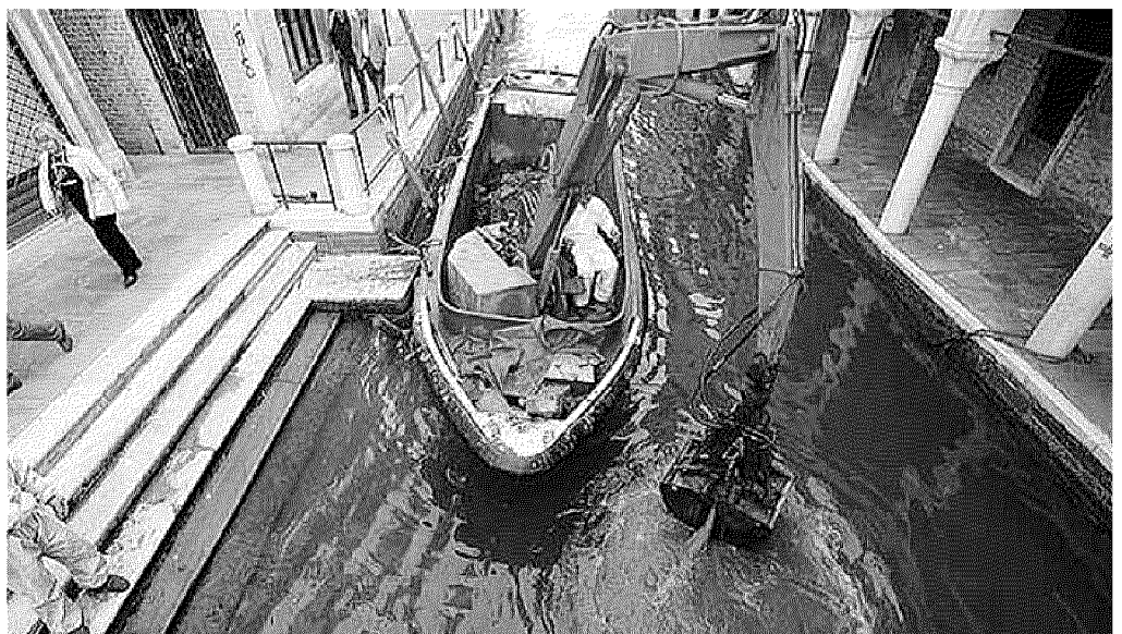
Lo scavo di un rio "in umido", ovvero in presenza di acqua
