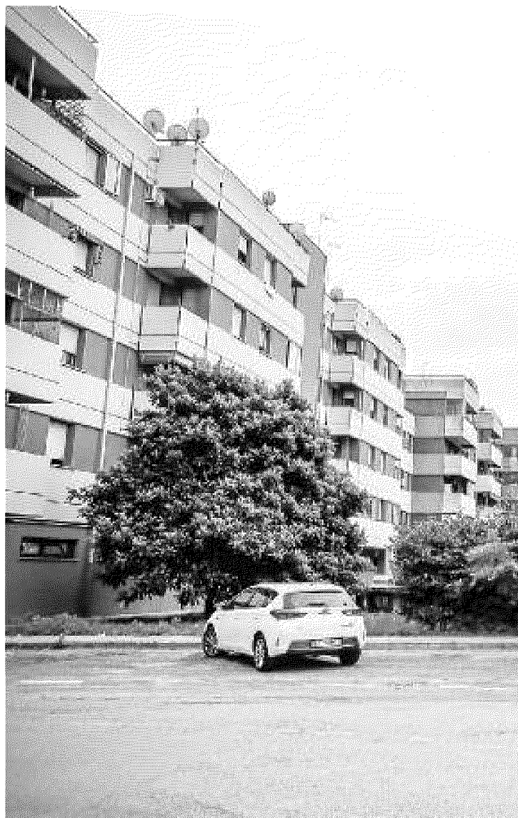
SCIOPERO DELL'AFFITTO I residenti lamentano la scarsa manutenzione degli alloggi da parte del Comune di Venezia
