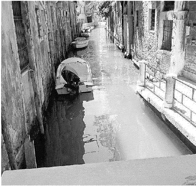
Rio dei Meloni, uno di quelli che verrà scavato
