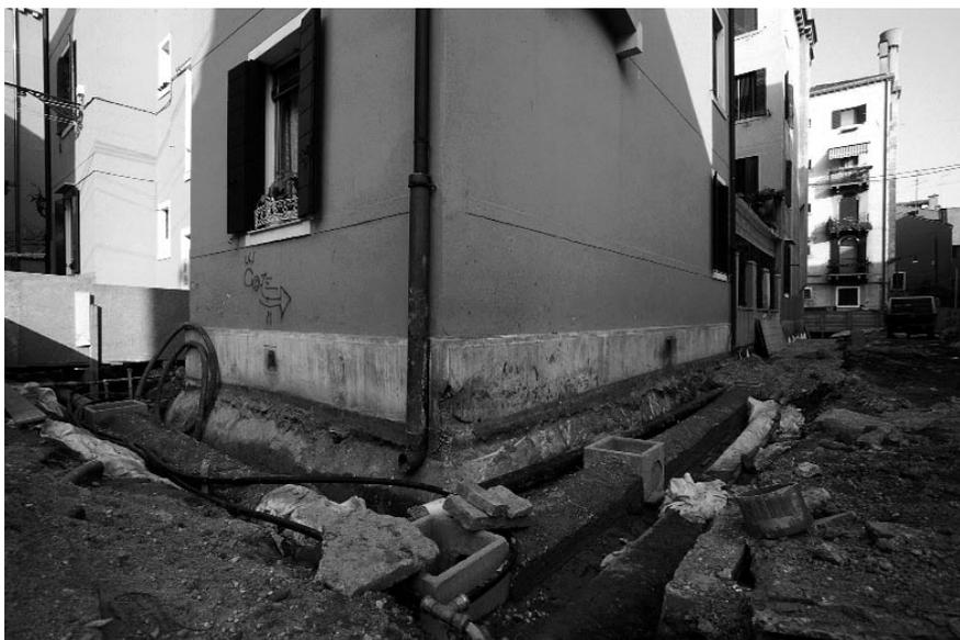
la rete che riceve i reflui delle abitazioni viene riunita in una vasca di raccolta e trattamento, che sarà raccordata alla tubazione presente nel canale di San Girolamo.
