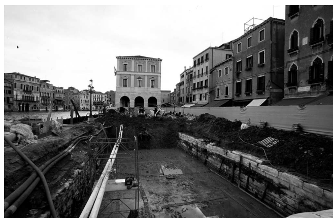
Campo de la Pescaria, le rive del 1398 (a destra) e del 1456 (a sinistra), lavori di costruzione del depuratore a cura di Insula spa.
