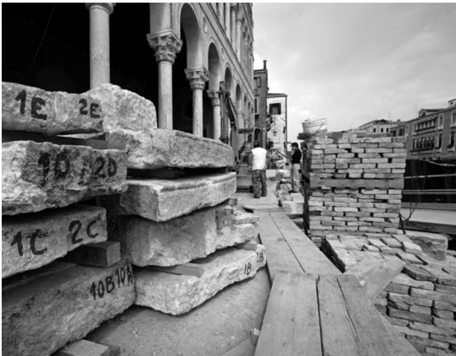
► *Ponte Longo, la collocazione delle travi restaurate e le reti dei sottoservizi, su struttura provvisoria.*
