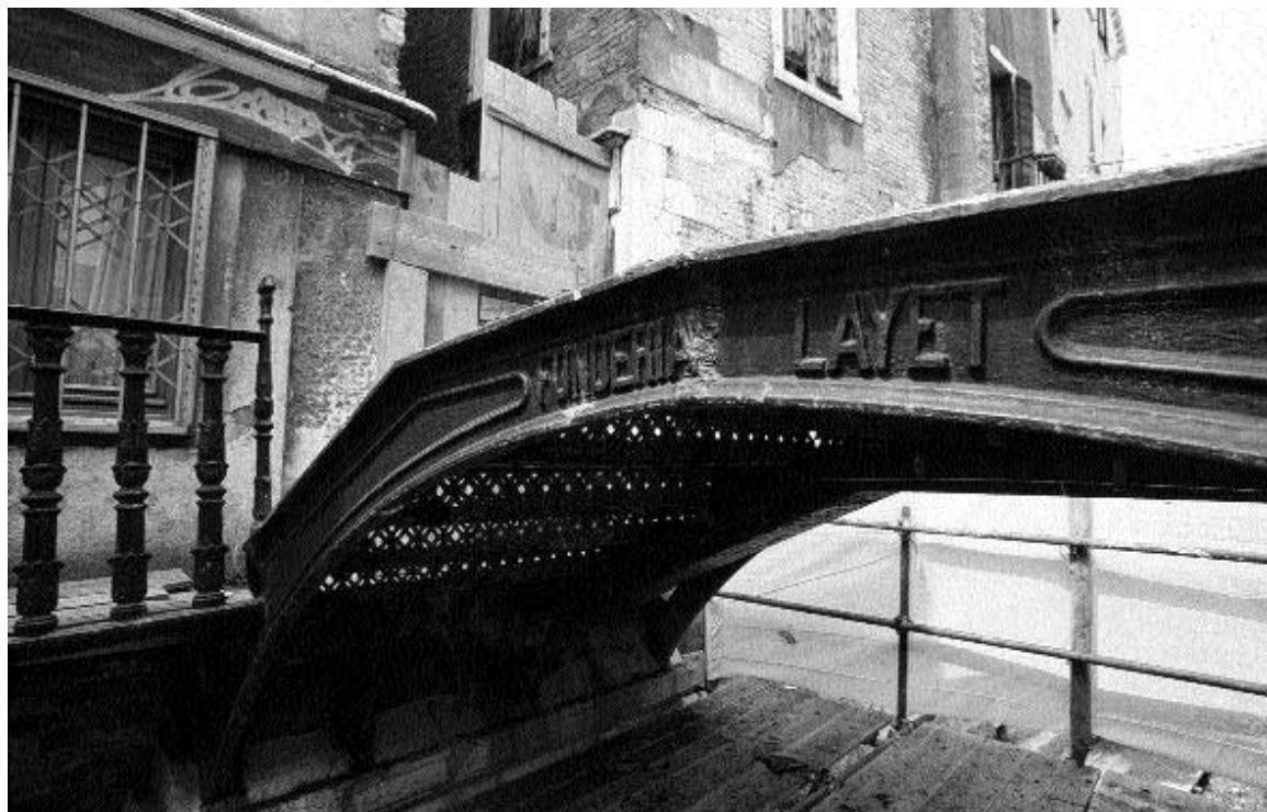
Il ponte della Donna Onesta durante le operazioni di smontaggio
