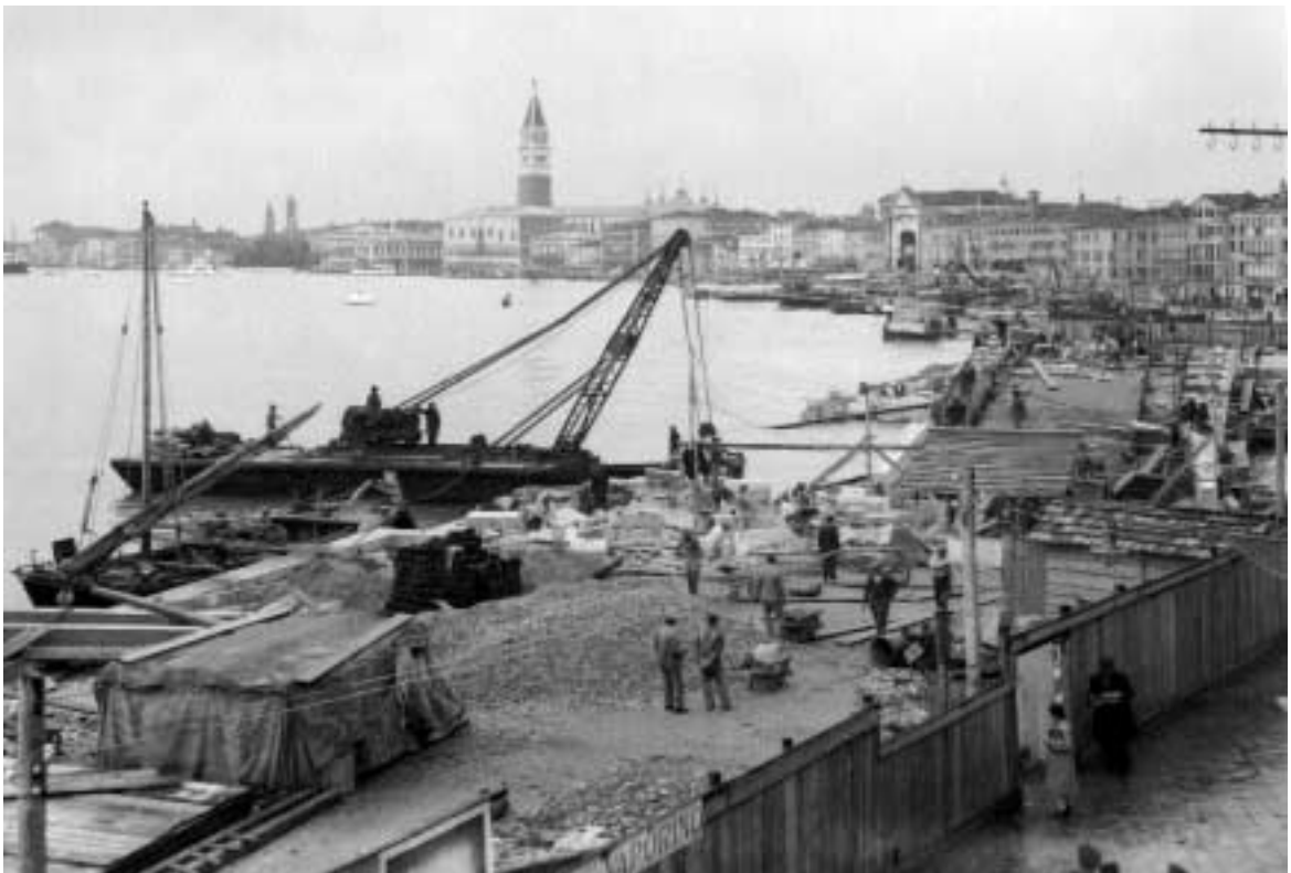
La costruzione della Riva dell’Impero (oggi Riva dei Sette Martiri), 1935
