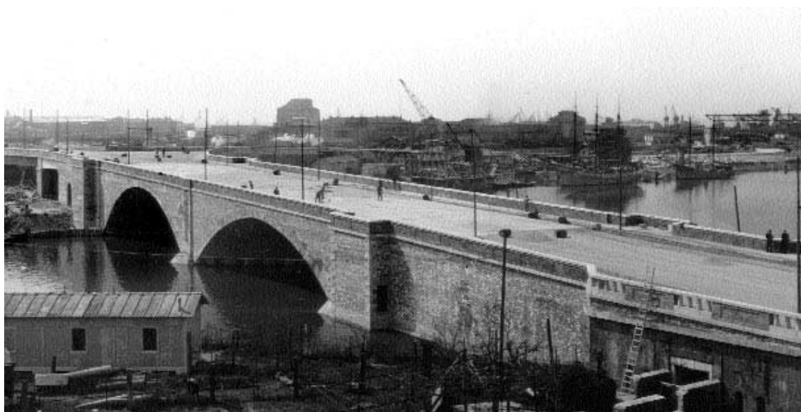
Il Ponte Littorio appena terminato, 1933
