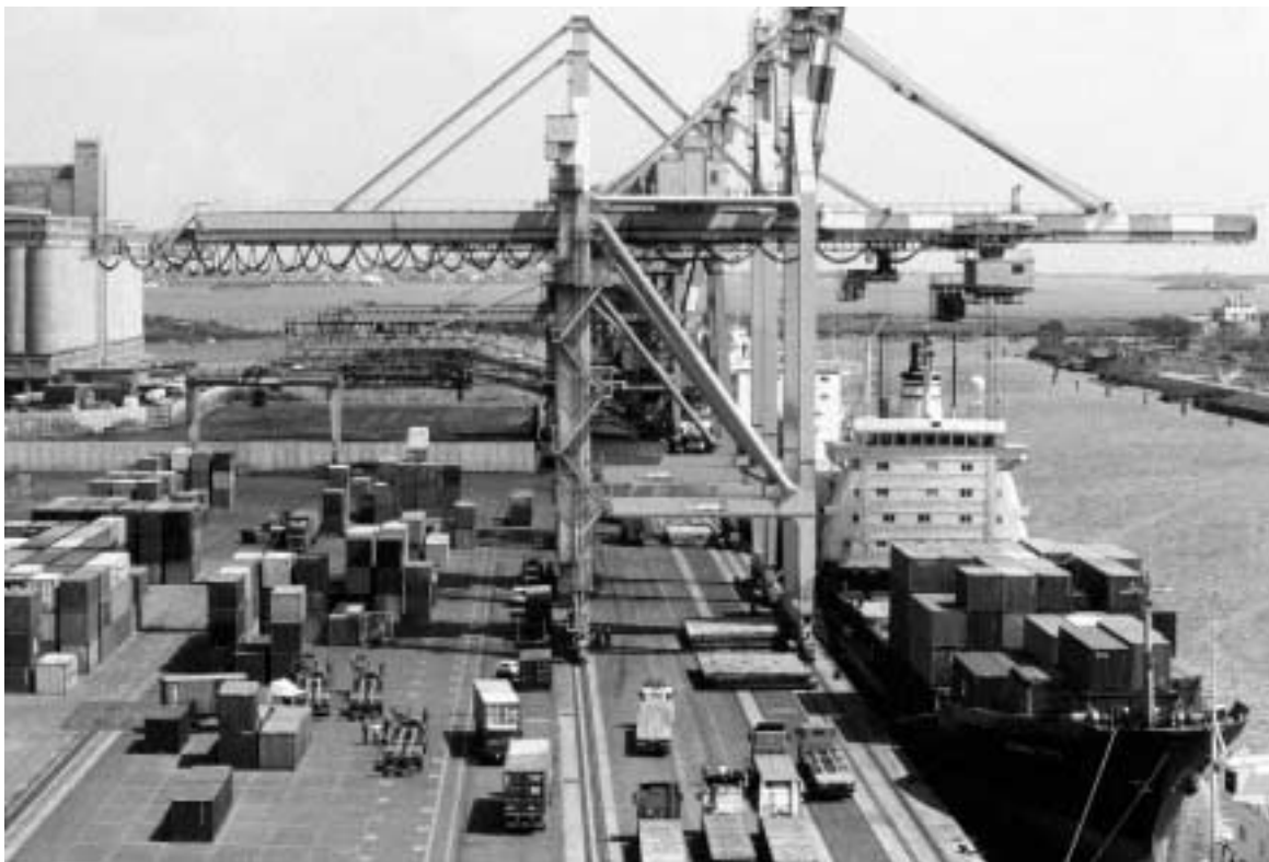
Il porto container
