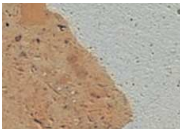
Fig. 10 - Macrofotografia dell'adesione fra malta di iniezione e laterizio
