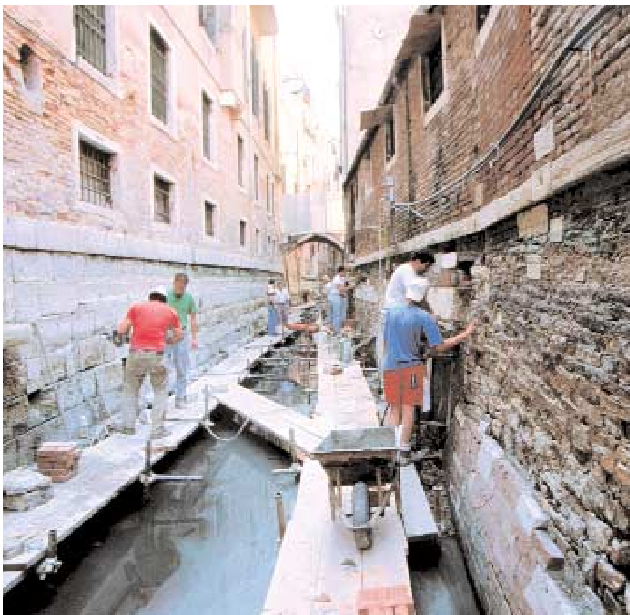
Manutenzione delle sponde in rio del Piombo, giugno 1999
