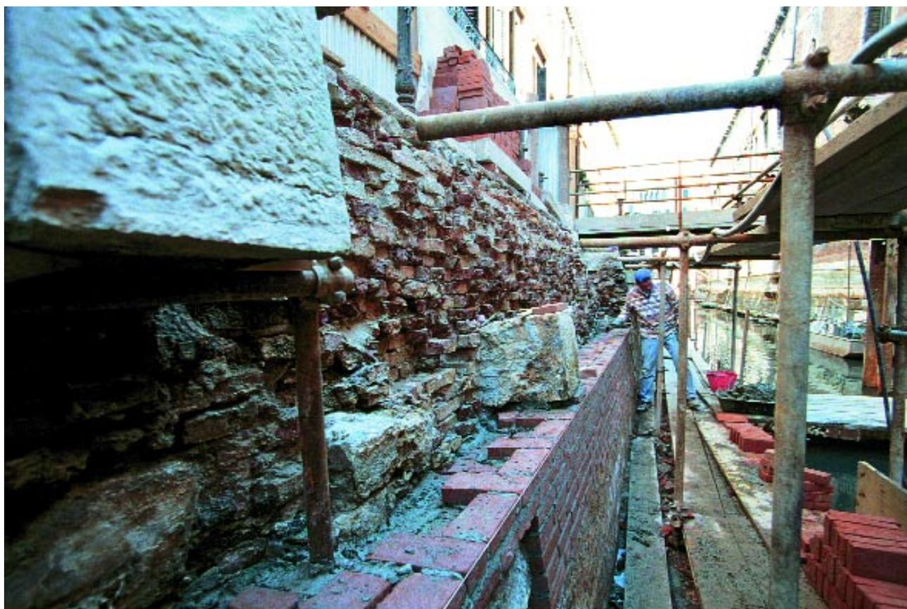
*Fig. 4 - Ricostruzione di un muro di sponda*
