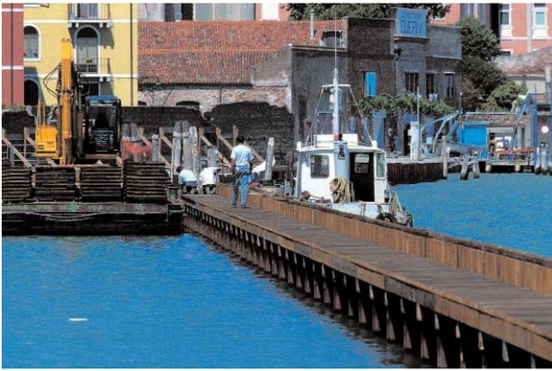
mc di fango asportati) per abbassare il fondale da -100 a -180 cm, è stata delimitata a nord e a est da un palancolato metallico rivestito in pannelli costituiti da tavole di larice comprese in un telaio di acciaio zincato.
