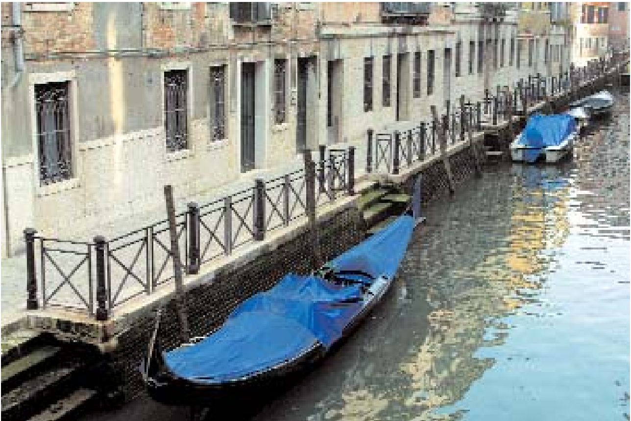
La fondamenta San Severo a restauro ultimato: l'innalzamento del paramento di sponda è stato realizzato con l'inserimento di mattoni pieni del tipo a mano, marzo 2001
