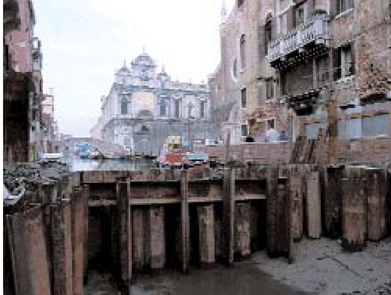
Rio dei Mendicanti, chiusura con palancole, gennaio 2000
