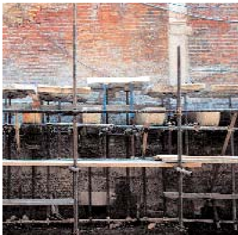
L'intervento con fibre di carbonio per il restauro dei barbacani, giugno 1998
