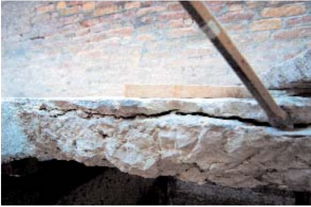
Il pessimo stato di consistenza fisico delle lastre di impalcato in pietra d'Istria di fondamenta San Giovanni Laterano, ramo basso, giugno 1998
