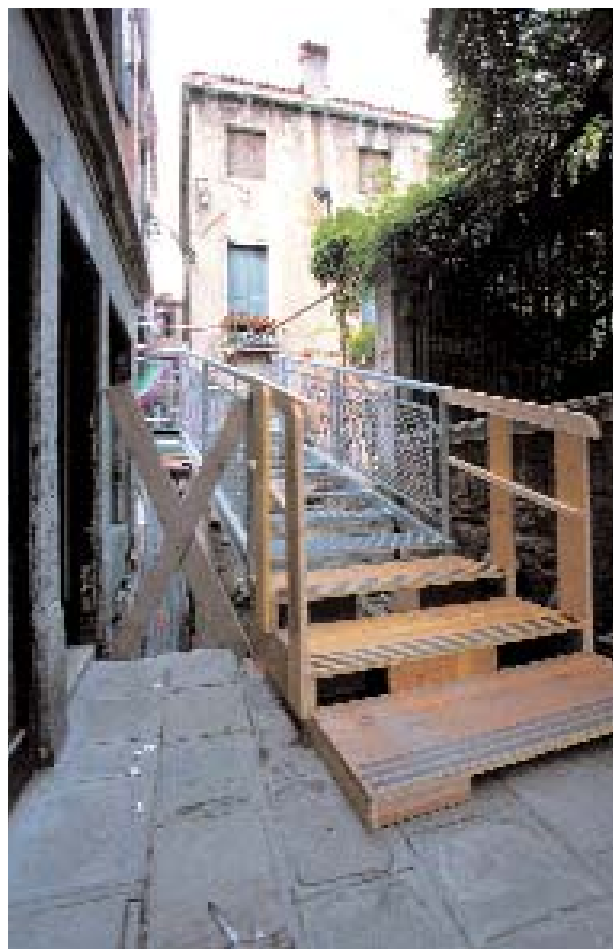
La passerella provvisoria realizzata durante il restauro di ponte delle "Paste", giugno 2000
