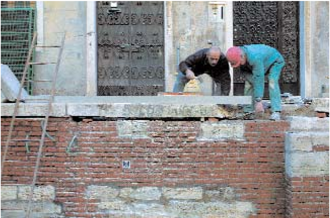
Posa della astolina di coronamento in fondamenta dei Preti, rialzata a +1,20 m slmm, febbraio 2001
