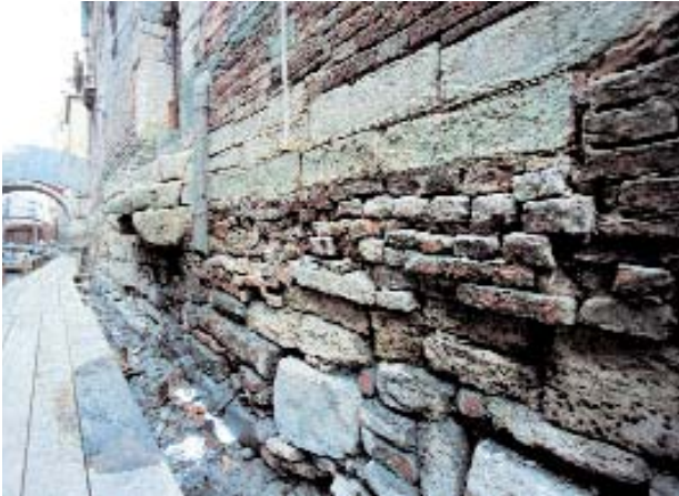
Degrado del muro di sponda in rio di San Giovanni Laterano, gennaio 1999
