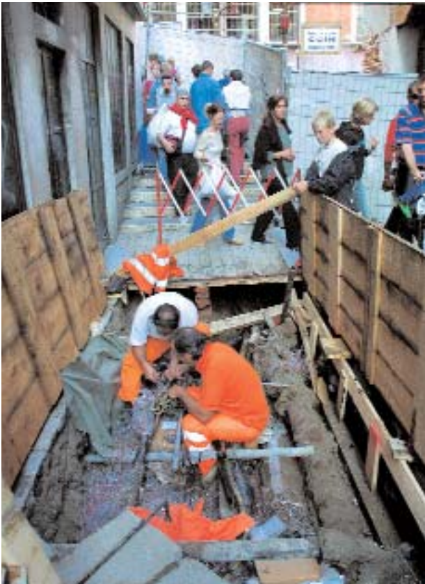
Interventi sui sottoservizi sui ponti dei "Giocattoli" e dell'Olio, marzo 1999 e settembre 2001
