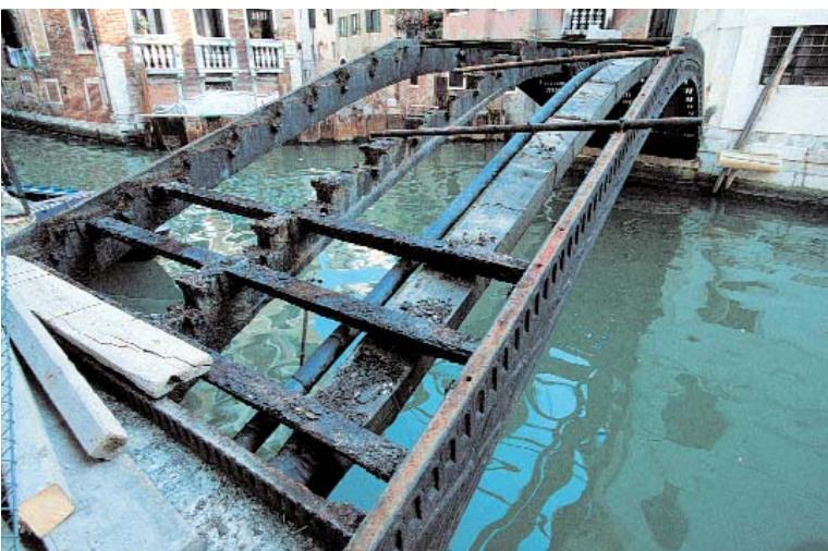
Il degrado delle arcate del ponte di Consafelzi, settembre 1998
