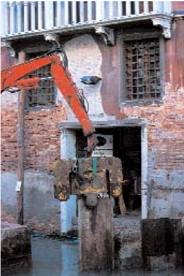
Infissione di palancole in rio di San Severo, novembre 1999
