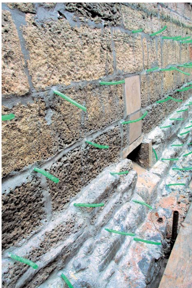
Rio del Mondo Novo, consolidamento del muro di sponda con malte colloidali, giugno 2001
