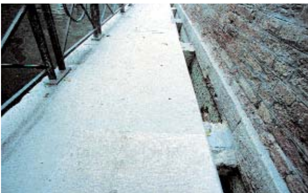
La fondamenta a restauro ultimato, settembre 1998
