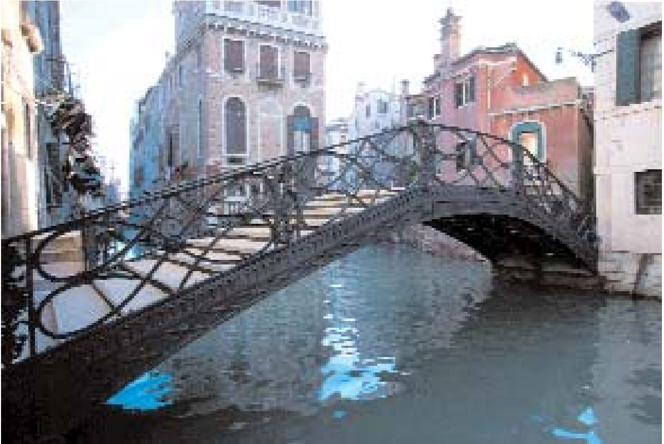
Il ponte di Consafelzi restaurato, dicembre 1999
