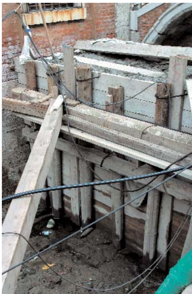
Chiusura di un rio con cassero ligneo
