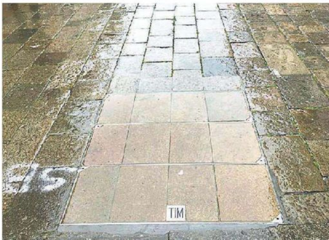
Pietre d'Istria sostituite e, in alto, un intervento con il flessibile
