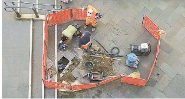
Masegni distrutti in uno dei cantieri aperti ■ VITUCCI A PAGINA 17
