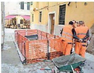
Un cantiere per i sottoservizi
