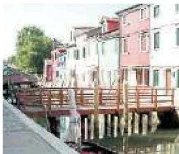
all'interno degli interventi integrati a Terranova». La passerella è in legno, con l'impalcato e il parapetto in legno di rovere, sostenuti da travi longitudinali in legno poggiate su pali di fondazione infissi nel fondale.
