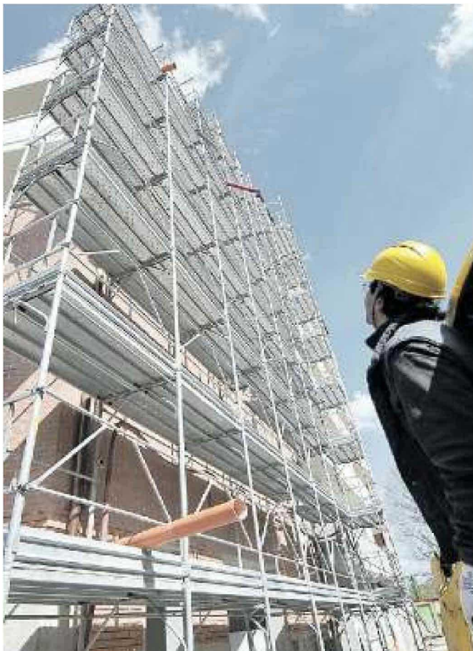
CANTIERI Lavori edilizi: il bando per l'autorestauro è stato un flop
