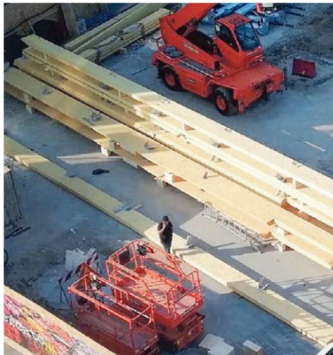
Il cantiere del mercato con le parti della copertura in legno
