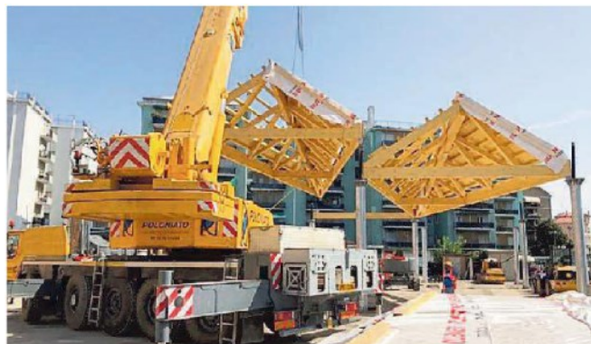
Il cantiere con la gru che trasporta le parti di tetto da montare
