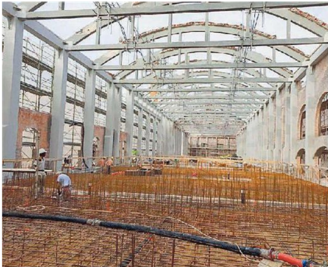
I lavori in corso per i 16 alloggi nelle ex Conterie
