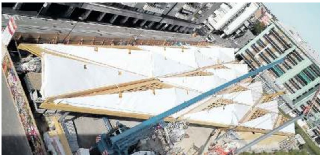
VIA FAPANNI Ieri le maestranze hanno completato la copertura del nuovo mercato fisso cittadino di via Fapanni che a fine ottobre sarà aperto
