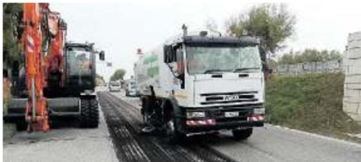
PELESTRINA L'asfaltatura della strada principale dell'isola
