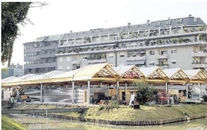
LAVORI IN CORSO Ci vorrà ancora un mese per completare l'allestimento del nuovo mercato coperto (Nuove Tecniche/Claudio Springola)
