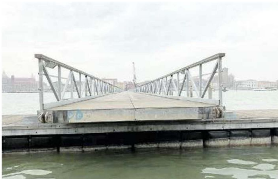
LAVORI ULTIMATI Il ponte provvisorio tra Fondamente Nove e il cimitero
