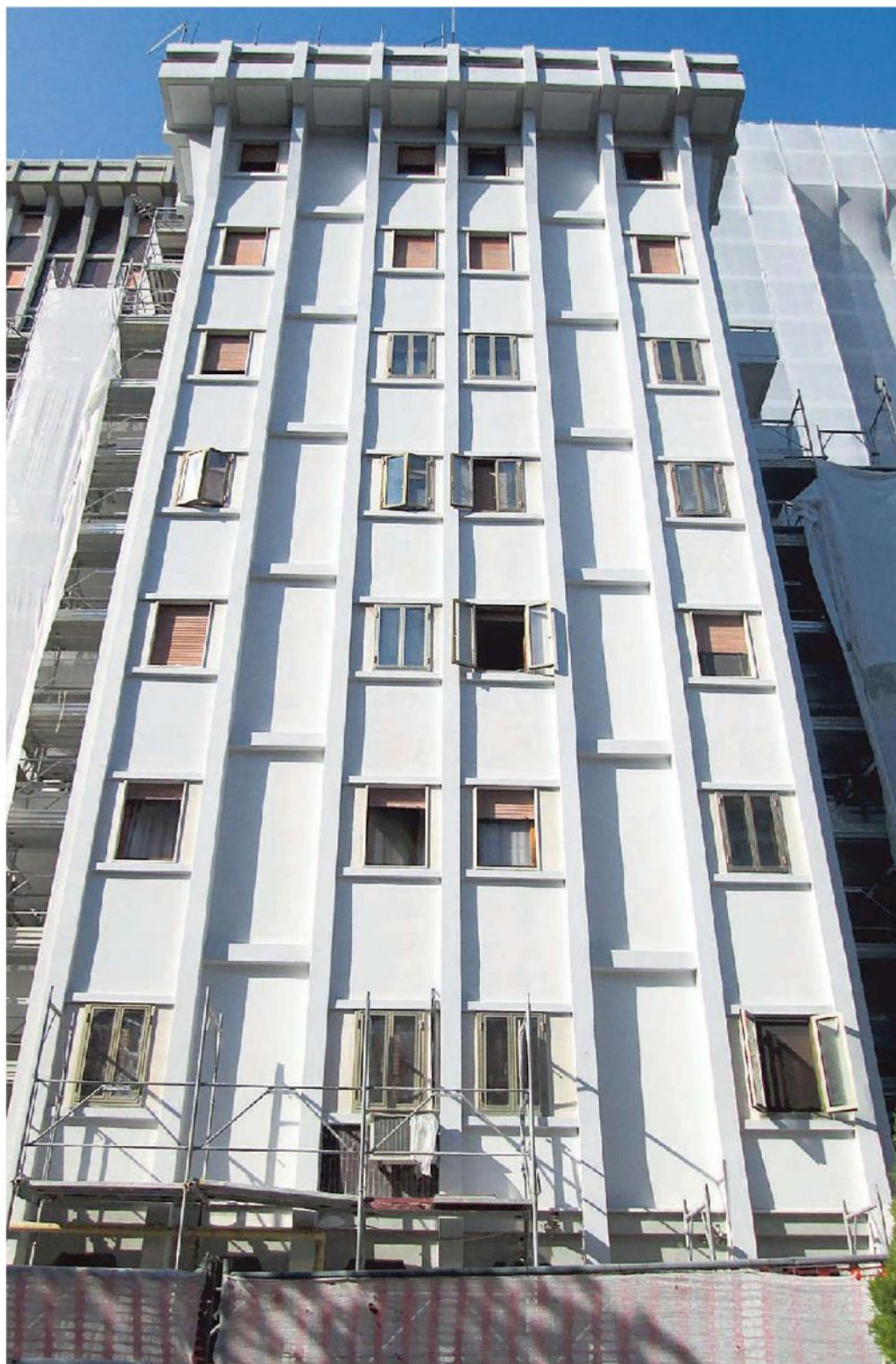
Il cantiere alla Torre 27 nel quartiere Cita di Marghera
