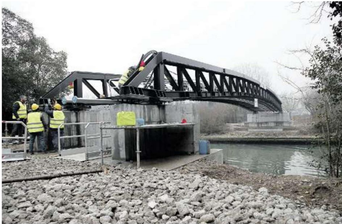
POSA Il nuovo ponte che collegherà Forte Marghera al polo universitario di via Torino
