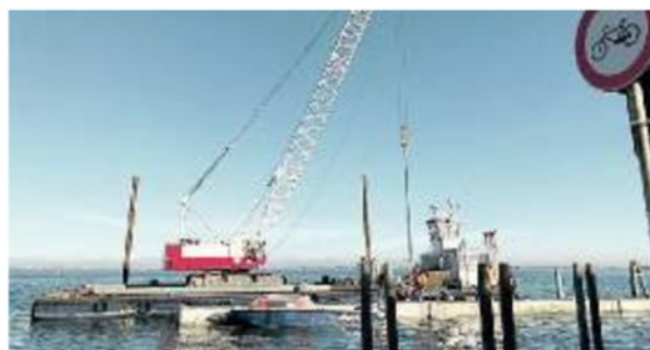
LAVORI IN CORSO La darsena in corso di ristrutturazione
