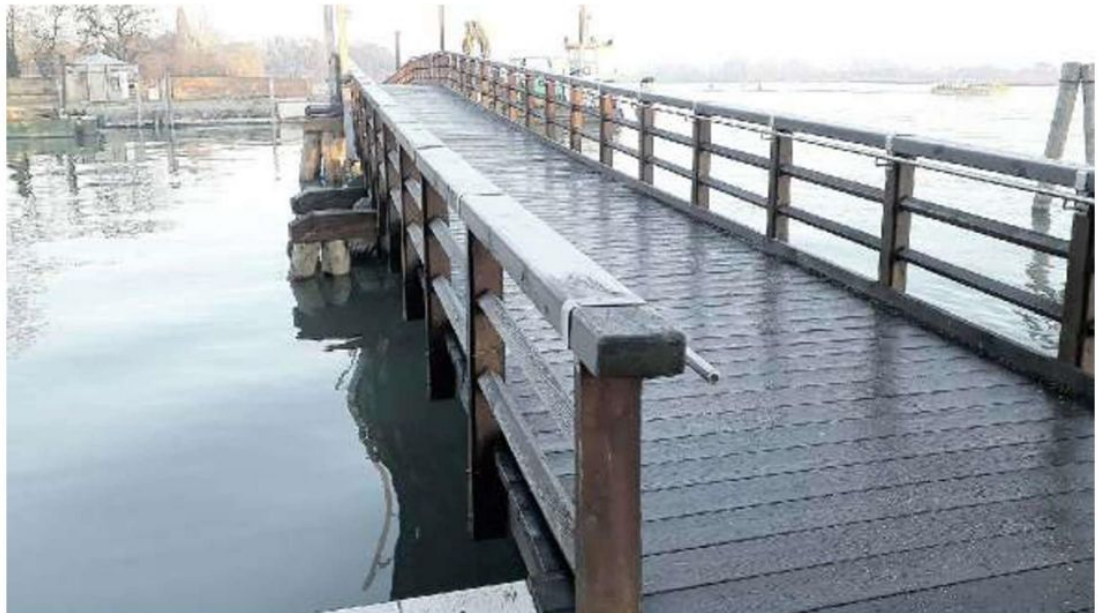
BURANO Uno scorcio del ponte Longo, che collega Burano a Mazzorbo, dopo i lavori eseguiti dal Comune
