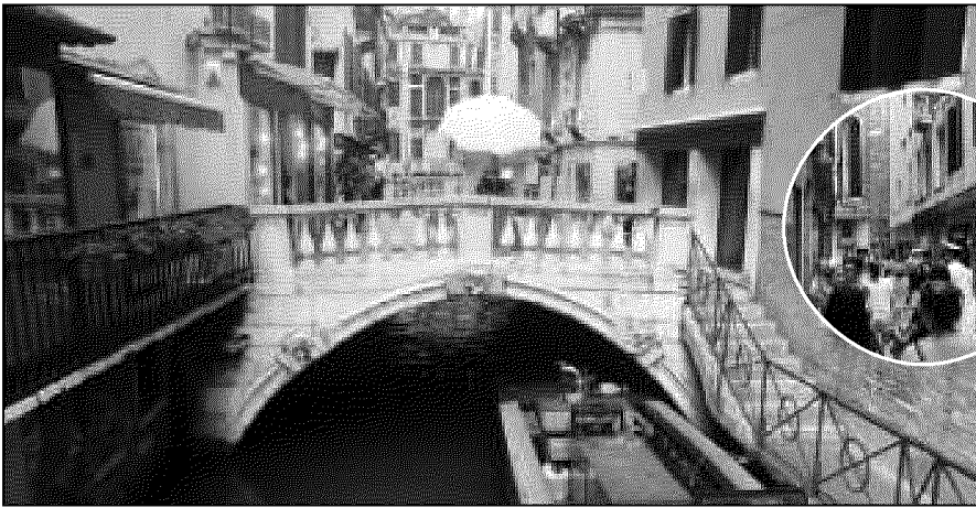
ALLARME CROLLI Sopra, il ponte dei Bareteri chiuso. Nel tondino, la ressa nelle calli
